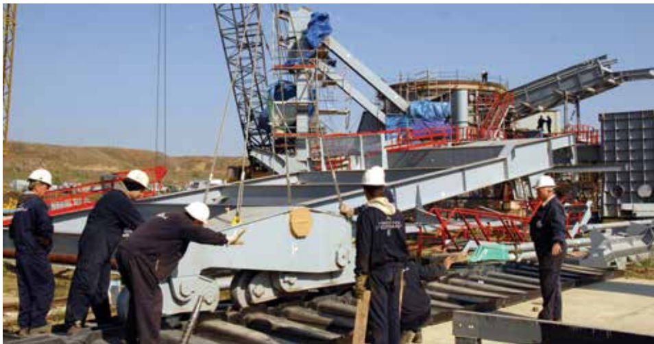
■ Монтажа багера на шестом БТО систему
